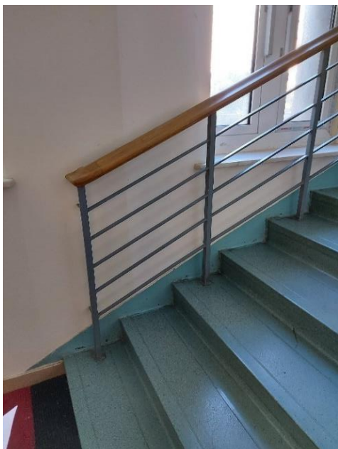
Zdjęcie nr 6. Schody w klatce schodowej
